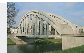
Železobetonový most v Karviné-Darkově
