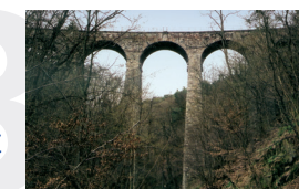
Železniční most v Žampachu
