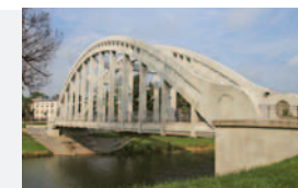
Železobetonový most v Karviné-Darkově
