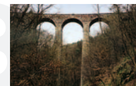
Železniční most v Žampachu
