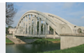
Železobetonový most v Karviné-Darkově
