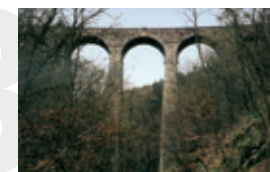
Železniční most v Žampachu
