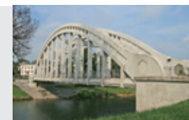
Železobetonový most v Karviné-Darkově
