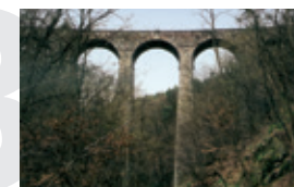
Železniční most v Žampachu
