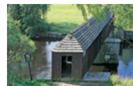
Dřevěný most v Lenoře
