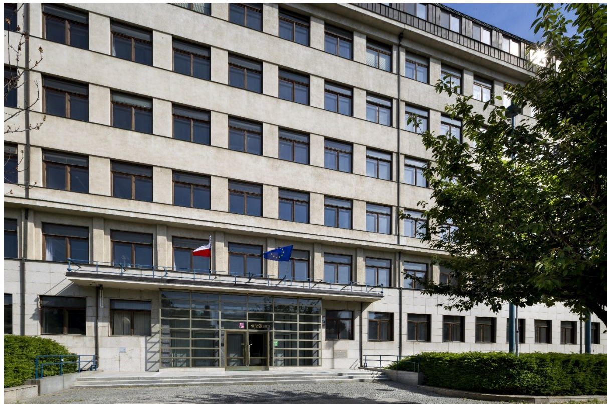
Budova Nejvyššího soudu v Brně
